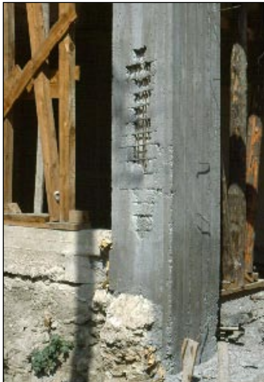
Μανδύας οπλισμένου ακυροδέματος, χυτού επί τόπου. Στη μια πλευρά διακρίνεται πλημμελής εφαρμογή του μανδύα λόγω πυκνών οπλισμών και μη χρήσης δονητή (αριστερά).
