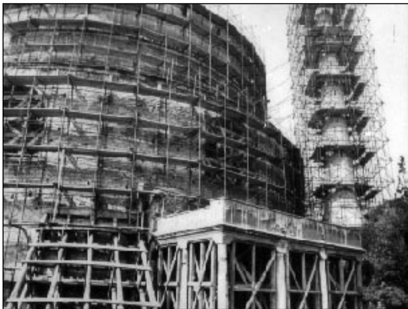
Εικόνα 13: Προσωρινή υποστήλωση της Ροτόντας εξωτερικώς μετά το σεισμό του 1978.
