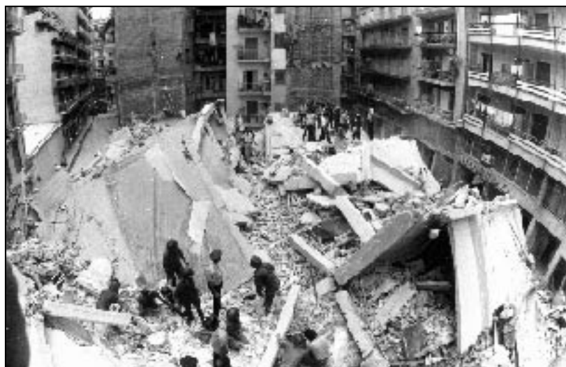
Εικόνα 5: Εικόνα από την κατάρρευση της 8-ωρόφου οικοδομής στην πλατεία Ιπποδρομίου.
