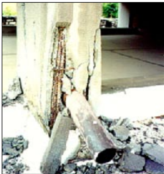
Συνέπειες κοντού υποστυλώματος σε συνδυασμό με «κακή» όπλιση και κακοτεχνία (Κόνιτσα 1996). [Αρχειο Ι.Ε.Αβραμίδη]
