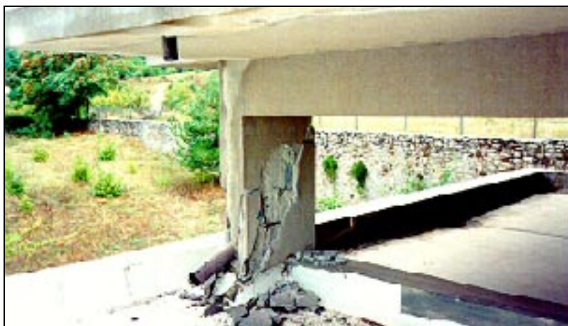
Συνέπειες κοντού υποστυλώματος σε συνδυασμό με «κακή» όπλιση και κακοτεχνία (Κόνιτσα 1996). [Αρχειο Ι.Ε.Αβραμίδη]
