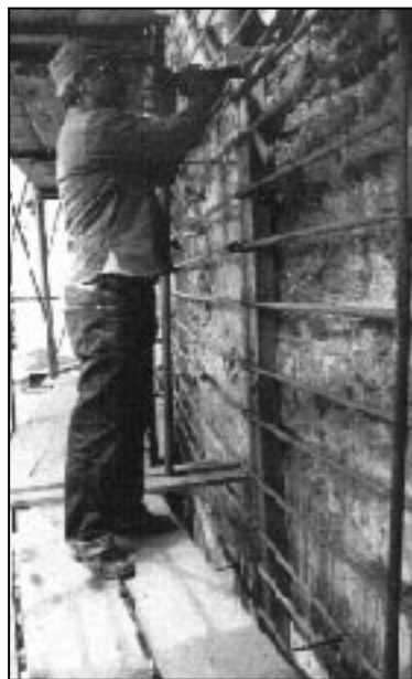
Εικόνα 14: Εργασίες αποκατάστασης στη Ροτόντα.
