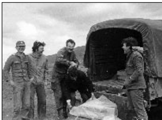
Φωτογραφία 2: Φοιτητές και στρατιώτες κατασκεύασαν τα βάθρα του Δικτύου Βόλβης.
