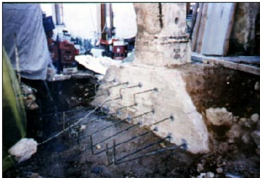
Διατμητικά αγκύρια κατά πλάτος επέκτασης θεμελίου από χυτό σκυρόδεμα.
