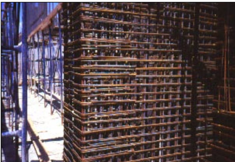
Εικόνα 17: Οπλιση αντισεισμικών τοιχωμάτων σε σύγχρονο κτίριο (Μέγαρο Μουσικής).
