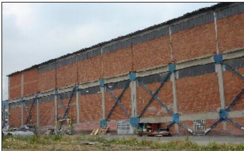
Προσεισμική ενίσχυση με χιαστί μεταλλικούς συνδέσμους. [Αρχείο Ι.Ε.Αβραμίδη]
